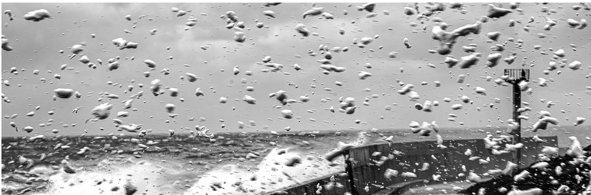
Quand la digue divague Digue Carnot - février 2022
